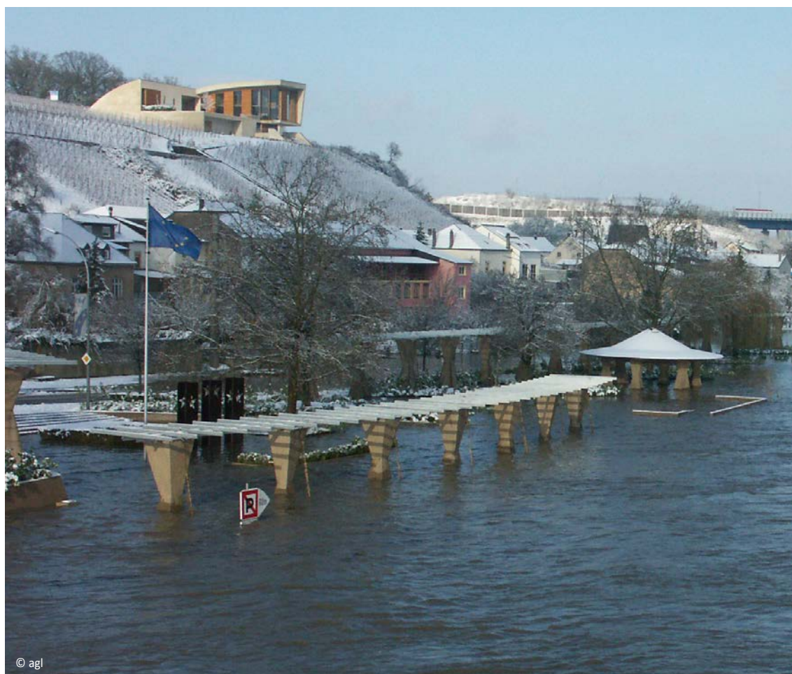
Hochwasser an der neuen Uferpromenade von Schengen (Dezember 2010)
